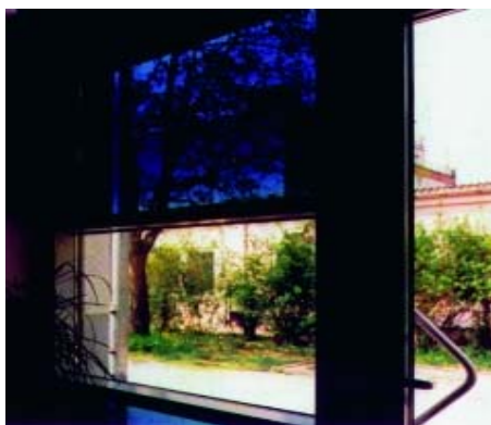
Rys. 10. Okno ze szkleniem gazochromatycznym (góra: faza ściemniona; dół: faza spoczynku) [10]
